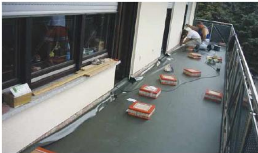
Die Bahnen der Abdichtungsfolie werden bereits in der Werkstatt maßgenau zusammengeschnitten und auf der Baustelle nur noch ausgelegt und an den Rändern verklebt.
