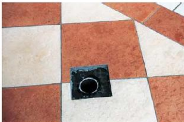
Auch die Bodenabläufe mit Dichtmanschetten werden von Rudolf Münkler in der eigenen Werkstatt gefertigt.
