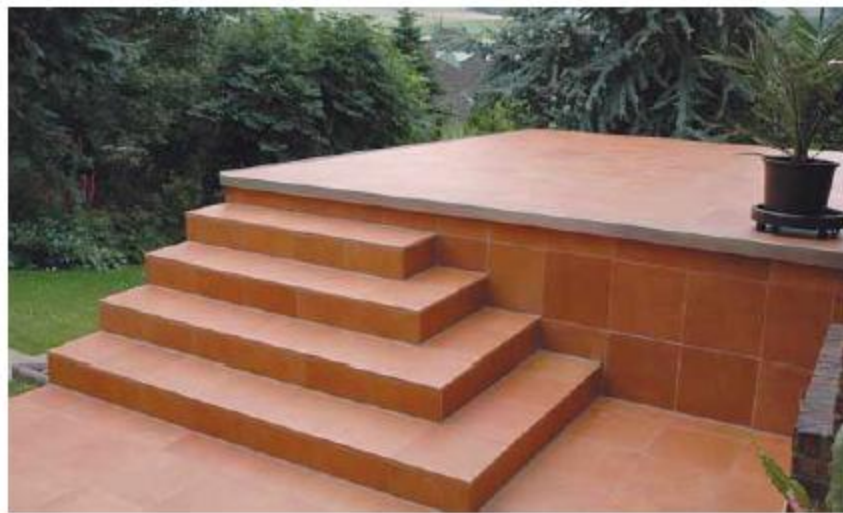
Auch Stufen können mit dem System ausgebildet werden. Am Terrassenrand ist das zum System gehörige Traufprofil gut zu erkennen.
