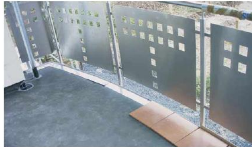
Die Fliesen werden lose aufgelegt und am Außenrand vom Randprofil gehalten.
