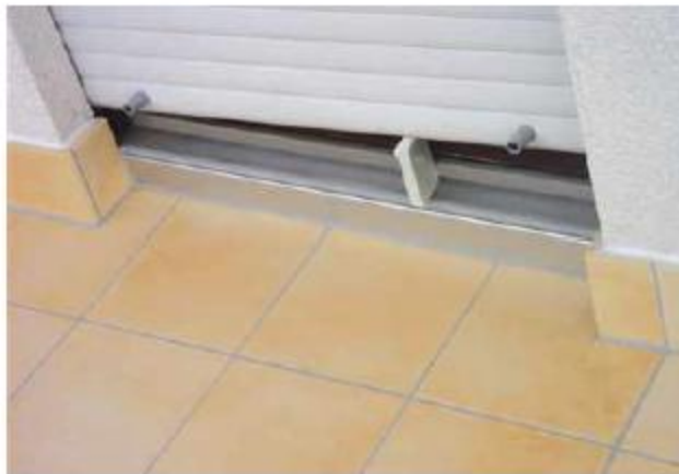
Auch Stufen können mit dem System ausgebildet werden. Am Terrassenrand ist das zum System gehörige Traufprofil gut zu erkennen.
