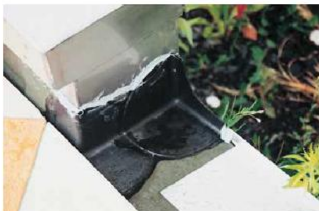
Für die Eckausbildung der Abdichtung stehen spezielle Formteile zur Verfügung, die mit aus der Flachdachabdichtung bekannten handwerklichen Techniken mit der Folie verschweißt werden.
